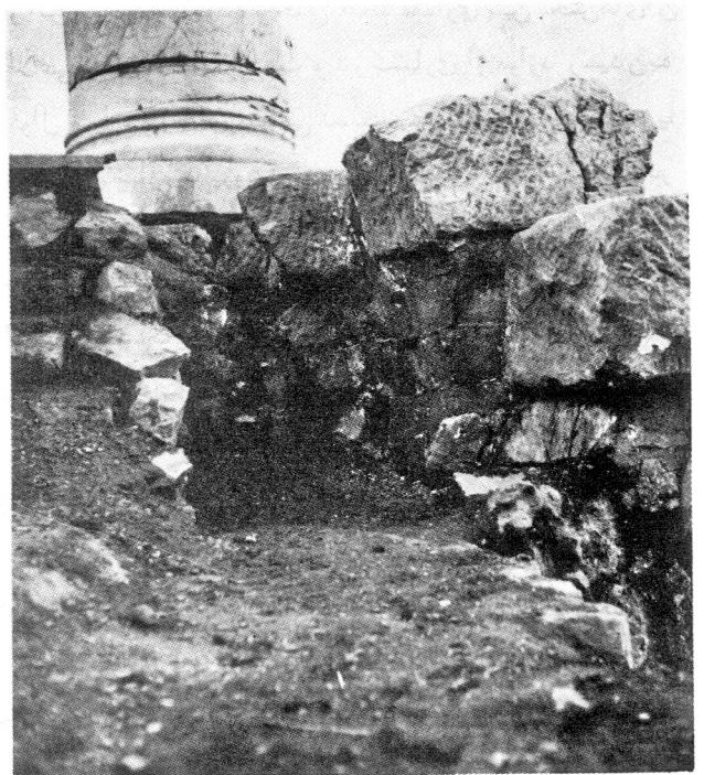
(تصویر ۳-۱۰) بخش شمالی جبهه غربی بنای باستانی . استحکام بخشیدن پوسته سنگ های نما همراه با پی بندی آنها با سنگ و ملاط ماسه سیمان در سال ۱۳۵۱
