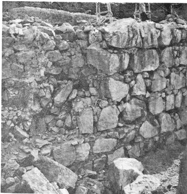
(تصویر ۳-۷) بخش مرکزی بنای باستانی . نمای جنوبی بخش فرو ریخته دیوار مرکزی که ملاط گچی درون آن فرسوده و شسته شده است . ۱۳۵۱
