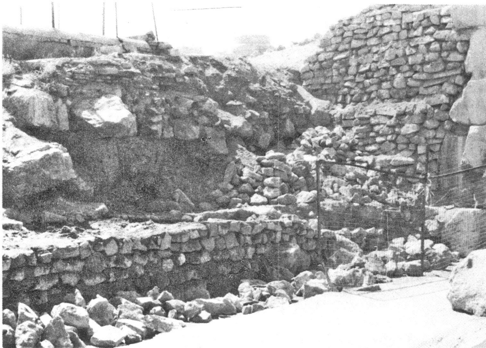
(تصویر ۱-۱۲) آماده سازی فضای پشت سنگهای نما برای نصب آنها در بردیوار غربی دید دیدبه سوی جنوب پیش از سال ۱۳۶۵
