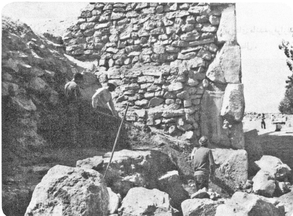
(تصاویر ۲-۱۱) خاکبرداری از آوار جانشین شده در فضای پشت سنگهای تمامی دیوار غربی پیش از تعمیرات سال ۱۳۲۵ دیدبه سوی جنوب
