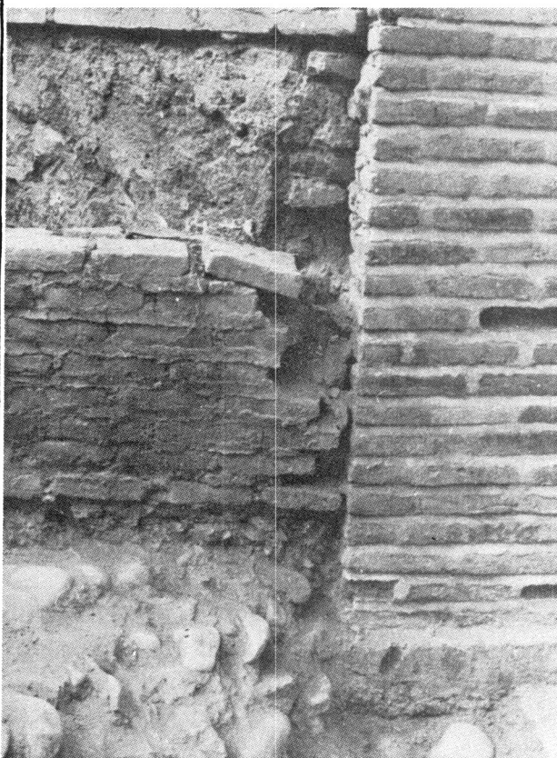
۲۴- گمانه سه - دید از شرق رو به غرب نمایش آثار شکستگی آجرها بر روی دیوار غربی اتاق که بمنظور ایجاد پخ در اتصال باینای اصلی ( کاخ ) بوجود آمده است .
