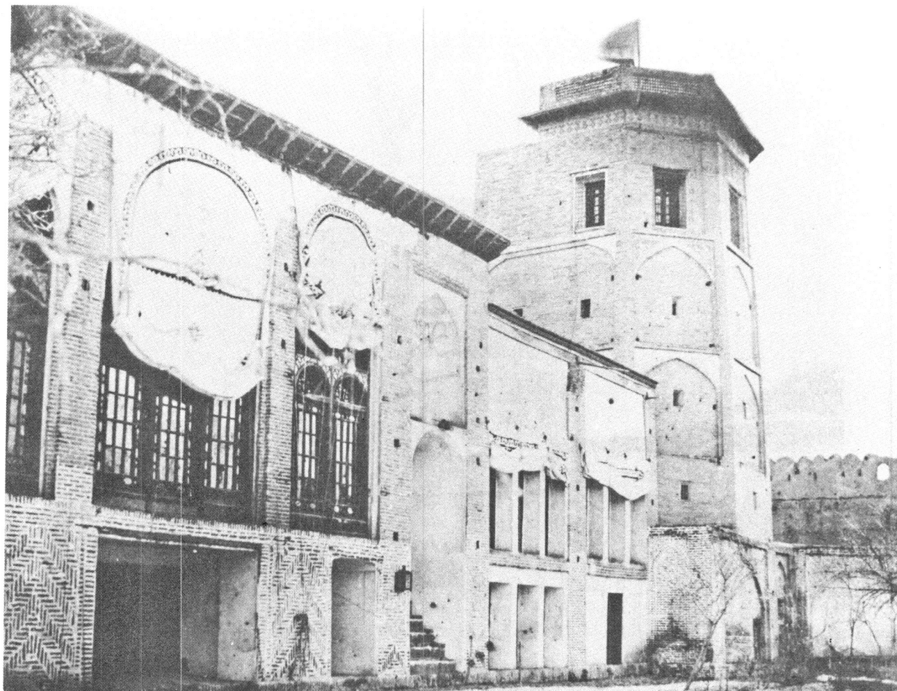
۳۷- دید از جنوب غربی
