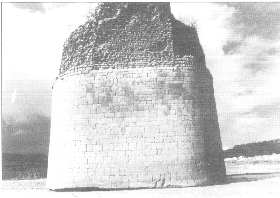
(شکل ۱۷). یکی از پایه‌های پل کشکان
