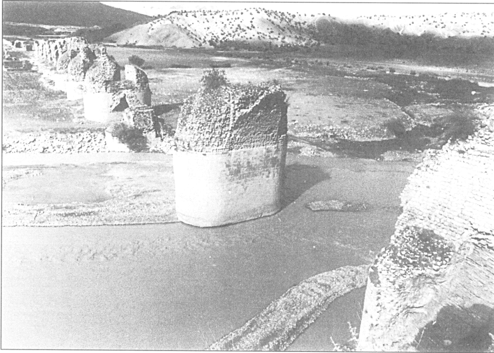
(شکل ۱۶). نمای جنوب شرقی پل کشکان
