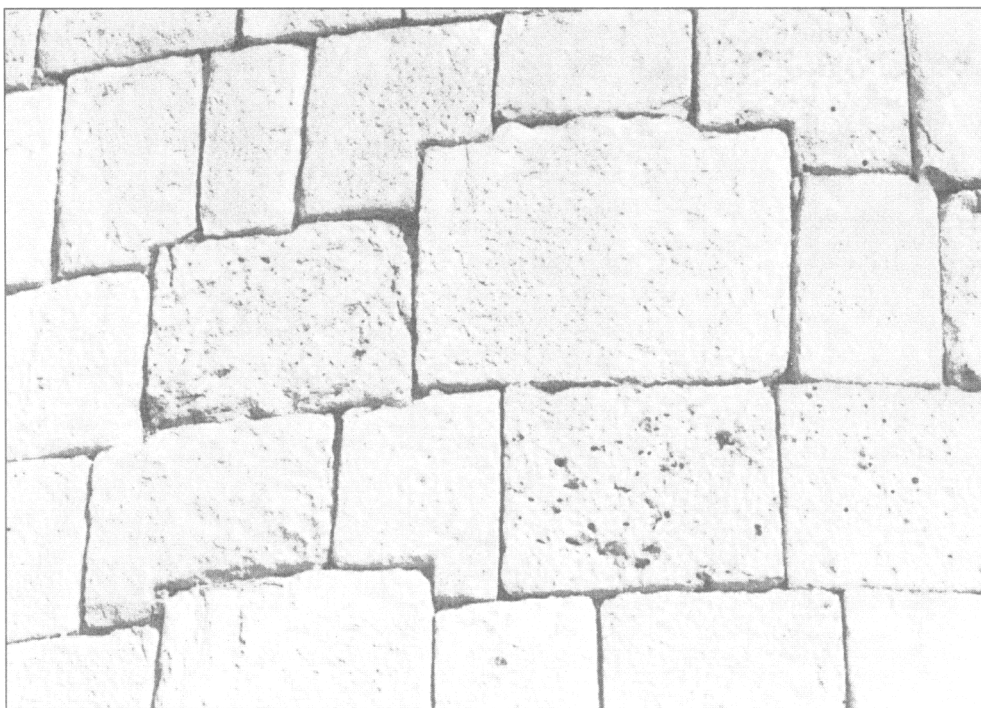
(شکل ۲۰). نحوه چفت و بست در سنگ چینی نمای پل کشکان
