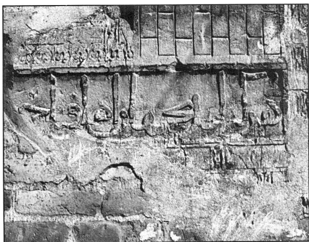
تصویر ۶ - بقایای کتیبه خط ثلث گچی اتاق تخریب شده
