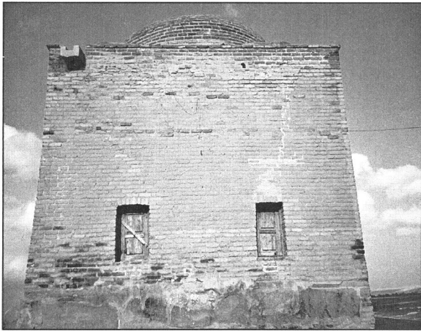
تصویر ۳ - نمای غربی بقعه خضر همدان
