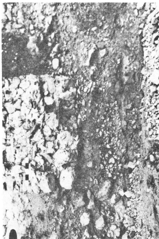
تصویر ۱۰ د. مقطع بخشی از دیوار محوطه میدان که ناشی از آب سردگی است.
