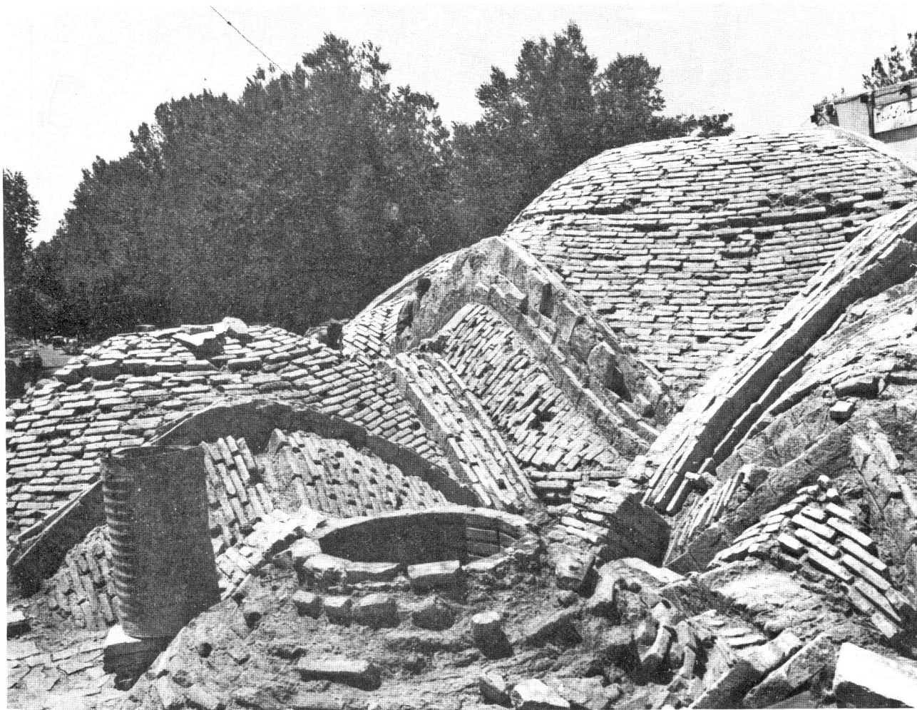
ساخت و ساز پوشش رختکن حمام خسرو آقا در حین مرمت و بازسازی
