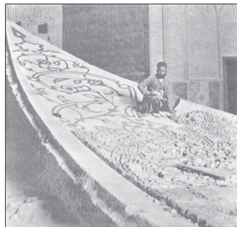
تصویر ۷- قالب معکوس یک قطاع گنبد. (مأخذ: Pope: 1931)
