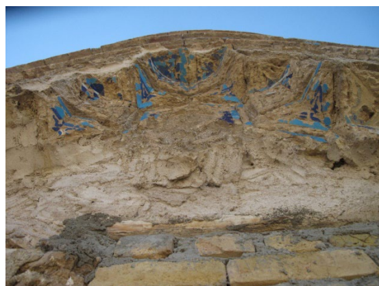
شکل ۱۱. نمایی از تزیینات خارجی بنا
