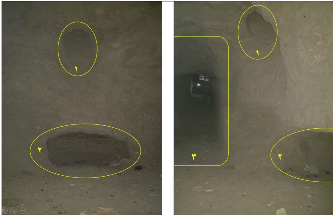
تصویر ۵. تصاویری از فضای داخلی پایاب شاخه شیرین قنات زارچ؛ ۱) میله چاه انتهای پایاب، ۲) مسیر جریان آب قنات در گذشته که در حال حاضر حدود دو متر از آن آزادسازی شده و مابقی مسدود است، ۳) پلکان ورودی پایاب، زاویه دوربین در تصویر سمت راست از انتهای پایاب به سمت ورودی پایاب است و در تصویر سمت چپ در امتداد مسیر حرکت آب قنات (در گذشته)، تاریخ تصاویر ۱۴۰۳.۷.۲۲، عکس از نگارندگان
