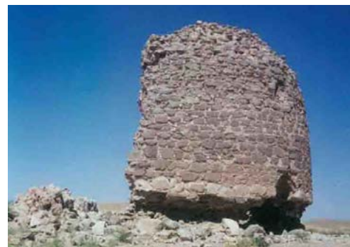
تصویر ۲۲، نمای برج ینگی ارخ پیش از مرمت که نیمی از آن تخریب شده بود (زنوری، ۱۳۸۰).
