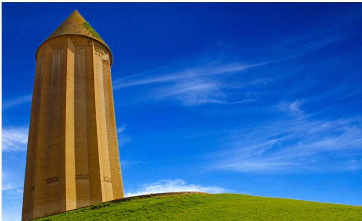
شکل ۱. نمایی از برج تاریخی گنبد کاووس
