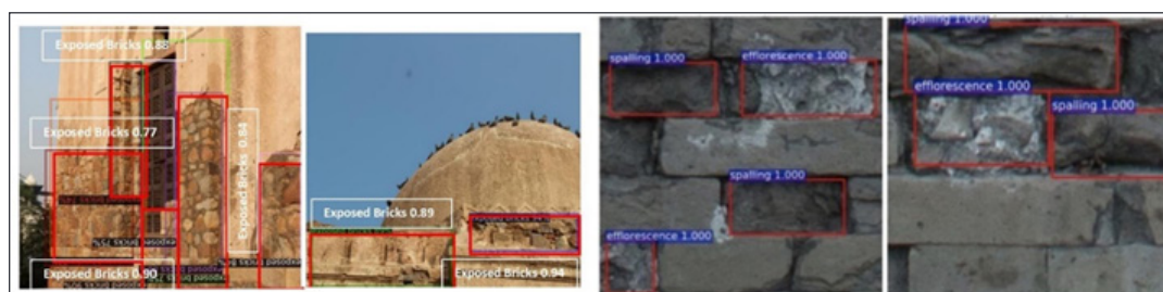
شکل ۱۷. نمونه‌هایی از سیستم‌های بازرسی بصری به کمک هوش مصنوعی برای عیوب سطح: (چپ) استفاده از YOLO برای تشخیص آسیب‌های سطحی در مطالعه موردی، (راست) شناسایی آسیب‌های ناشی از شورم‌زنی و پوسته شدن. (Mishra & Lourenço, 2024).
