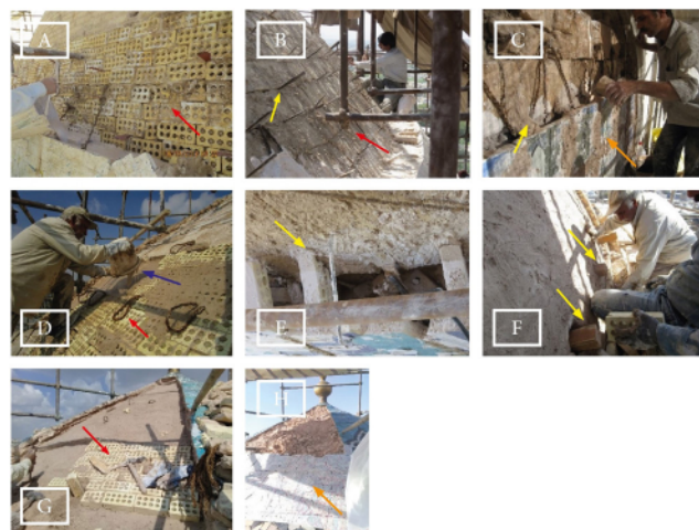
شکل ۱۲. A, B, D, G (فلش قرمز): نصب آجرهای پکفته؛ B, F (فلش زرد): نصب کفگیرک‌ها؛ C, H (فلش نارنجی): نصب پارچه‌های کاشی، C, E (فلش زرد): نصب داراب؛ A, C, D (فلش آبی): دوغاب‌ریزی بین پارچه‌ها و زیره (سازمان میراث فرهنگی اصفهان، ۱۴۰۲).
