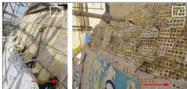
شکل ۶. قسمت دوجابریزی (فاصله بین کاشی‌ها و زیره گنبد) مسجد جامع عباسی؛ A- قبل از دوجابریزی ۱۳۹۴. ش؛ B- پس از دوجابریزی ۱۳۹۷. ش. (افشار، ۱۴۰۲).
