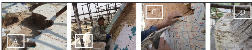
شکل ۱۳. A- پارچه‌های کاشی دارای زائده B, C- اصلاح و افزودن برخی قطعات کاشی پس از نصب پارچه‌ها روی گنبد D- پس از گیرش دوغاب (سازمان میراث فرهنگی اصفهان، ۱۴۰۲).
