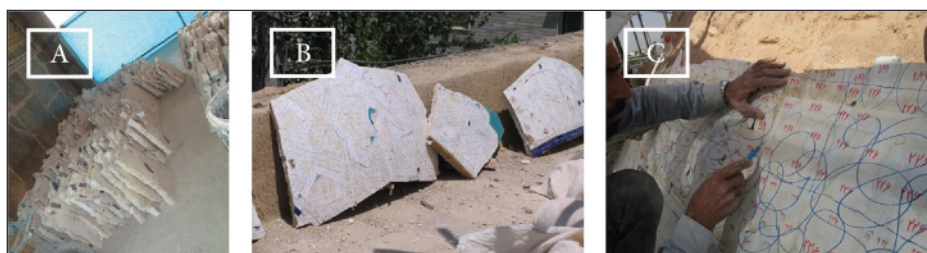
شکل ۹. A- کاغذهای چسبیده به سطح پارچه‌های کاشی؛ B- پارچه‌های کاشی آماده شده جهت نصب روی گنبد مسجد جامع عباسی؛ C- پارچه‌های کاشی نصب شده روی گنبد در مرمت اخیر شیخ لطف‌الله (A, C: سازمان میراث فرهنگی اصفهان، ۱۴۰۰؛ B: عنایتی، ۱۳۹۵).
