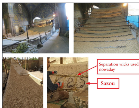
شکل ۱۰. قرارگیری پارچه‌های کاشی معرق نره به‌صورت معکوس بر روی سطح قالب منحنی؛ بالا: قالب گنبد مسجد جامع عباسی؛ پایین: قالب گنبد مدرسه چهارباغ (بالا: سازمان میراث فرهنگی اصفهان، ۱۴۰۰؛ پایین: پنجه‌پور، ۱۴۰۲).
