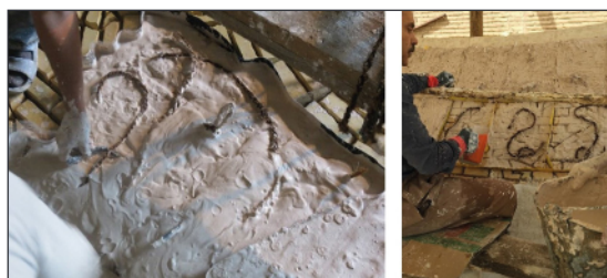
شکل ۴. گنبد مدرسه چهارباغ. ملاط ریزی گچی در پشت قطعات کاشی معرق نره (پنجه‌پور، ۱۴۰۰).
