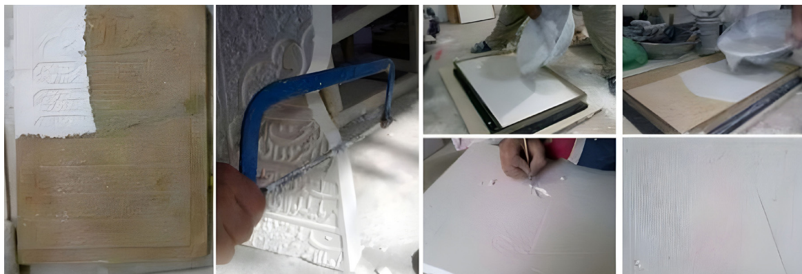
شکل ۸. قالب‌ریزی، انتقال و حجاری نقوش بر روی قطعه گچی و مدل‌سازی بخش مفقود
