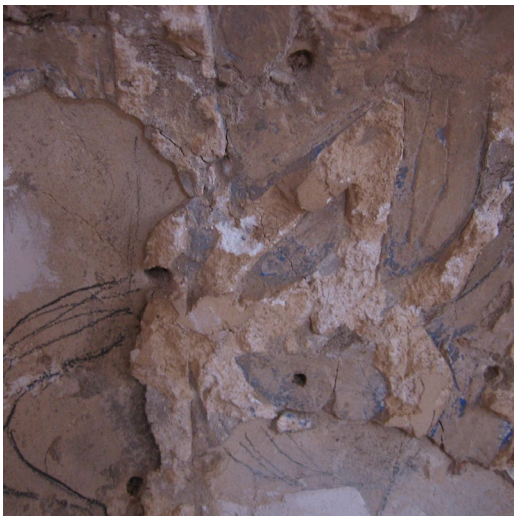
شکل ۲۶. راست: تخریب و ریزش کتیبه گچبری از بستر آن؛ چپ: نمای نزدیک نحوه تخریب و ریزش کتیبه گچبری از بستر آن (عکس از نگارنده)
