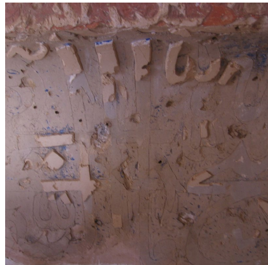
شکل ۲۶. راست: تخریب و ریزش کتیبه گچبری از بستر آن؛ چپ: نمای نزدیک نحوه تخریب و ریزش کتیبه گچبری از بستر آن (عکس از نگارنده)
