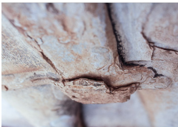
شکل ۶. آسیب تورق لایه سنگ بر روی آرامگاه خشیارشا
