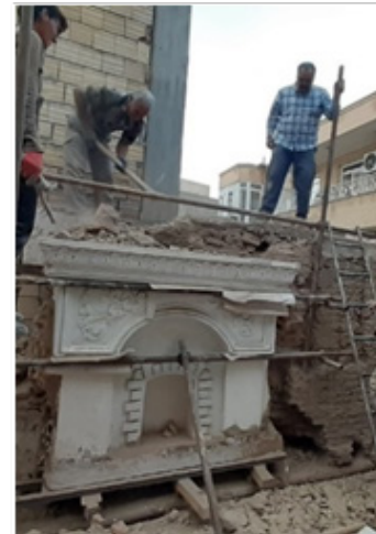
شکل ۱۸. تخریب بخشی از پشت کار و دیوارهای جانبی برای جاگذاری پروفیل. شکل ۱۹. تخریب پشت کار و اجرای قاب فلزی. شکل ۲۰. تکمیل قاب فلزی دور اثر (از راست به چپ)
