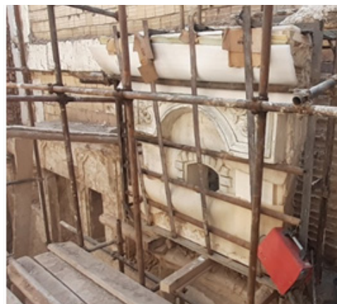
شکل ۲۳. خالی نمودن پشت کار و استحکام با گچ زنده شکل ۲۴: اتصال اثر بسته بندی شده به سازه نگهبان شکل ۲۵. مهار اثر بعد از بسته بندی کامل برای تخلیه پشت کار (از راست به چپ)
