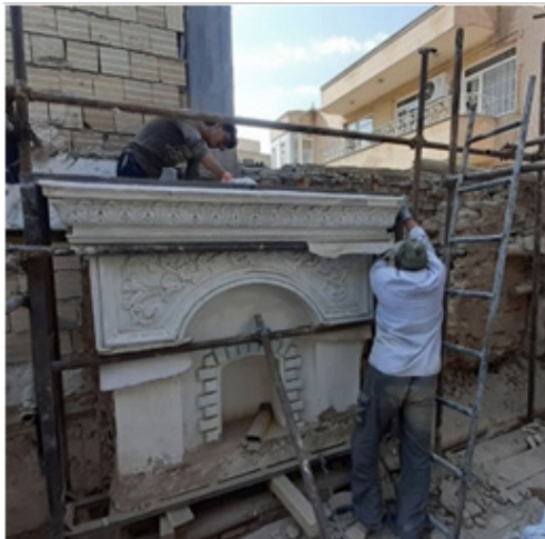
شکل ۱۸. تخریب بخشی از پشت کار و دیوارهای جانبی برای جاگذاری پروفیل. شکل ۱۹. تخریب پشت کار و اجرای قاب فلزی. شکل ۲۰. تکمیل قاب فلزی دور اثر (از راست به چپ)
