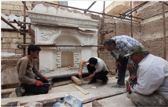
شکل ۱۷. جانمایی بستر فلزی در زیر کار
