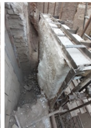
شکل ۲۳. خالی نمودن پشت کار و استحکام با گچ زنده شکل ۲۴: اتصال اثر بسته بندی شده به سازه نگهبان شکل ۲۵. مهار اثر بعد از بسته بندی کامل برای تخلیه پشت کار (از راست به چپ)
