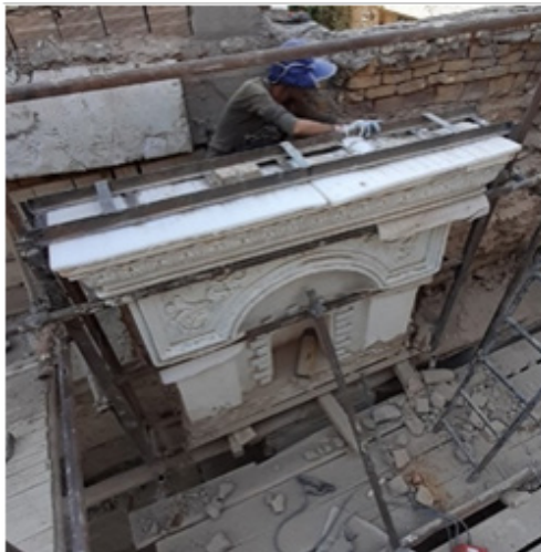
شکل ۲۲. آخرین مرحله اتصالات قاب فلزی
