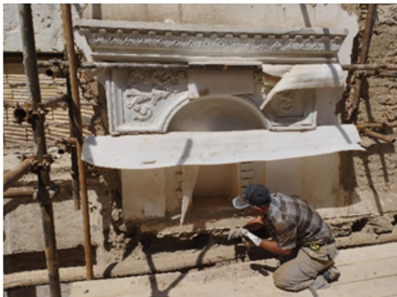
شکل ۱۳. ایجاد شمع کوبی در بخش تاج شومینه
