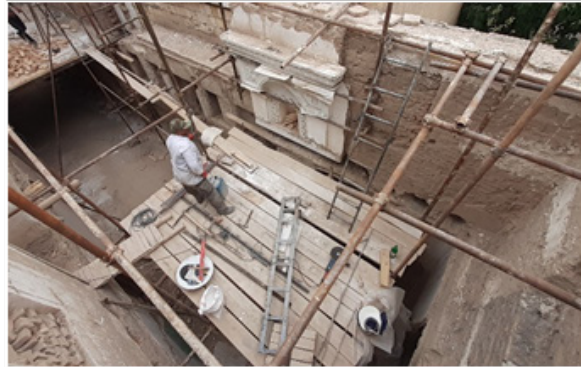
شکل ۱۶. ساخت بستر فلزی برای قاب بندی
